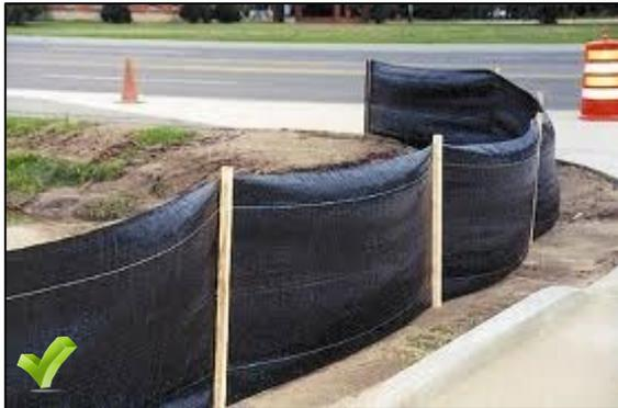
Las mallas protectoras deberán ser instaladas en áreas con problemas, para así prevenir que desechos salgan de esa zona. Nunca coloque una malla protectora frente a una corriente, ya sea de una zanja, cuneta o un canal de drenaje.
