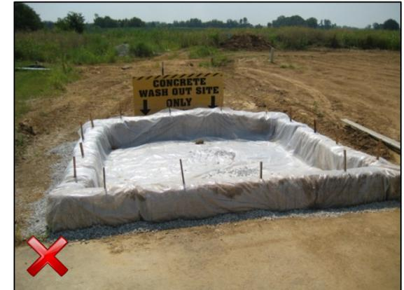
Los contratistas deberán utilizar mallas especiales para el concreto cuando lo estén vaciando o colocando. Estas mallas deberán ser utilizadas cuando se enjuague cualquier mezcla de concreto, durante el uso o cuando se limpien herramientas o equipos. No es permitido enjuagar equipos o herramientas fuera de la zona designada para tal uso.
