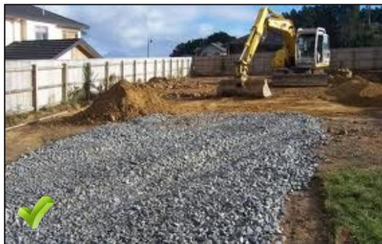
Cada zona de construcción deberá contar con una salida apropiada. La cual ayudará a mantener el lodo fuera del pavimento de la carretera y fuera del drenaje pluvial. Si el lodo o suelo de la zona de construcción es llevado a la carretera, esta deberá ser limpiada inmediatamente.
