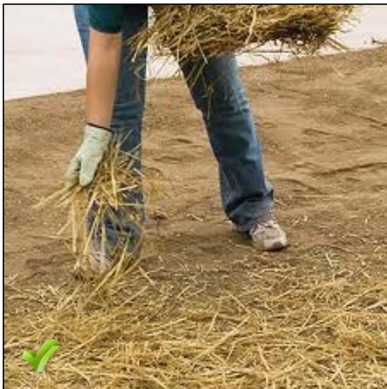
A la brevedad posible, el área de construcción deberá ser cubierta temporalmente con paja, o de manera permanente con tierra adecuada o pasto. Cuando la paja es utilizada, deberá asegurarse que ha sido comprimida de tal manera que no escape con el viento o la lluvia. Mantas para prevenir la erosión deberán ser utilizadas en áreas de desagüe como las zanjas, o zonas de drenaje.
